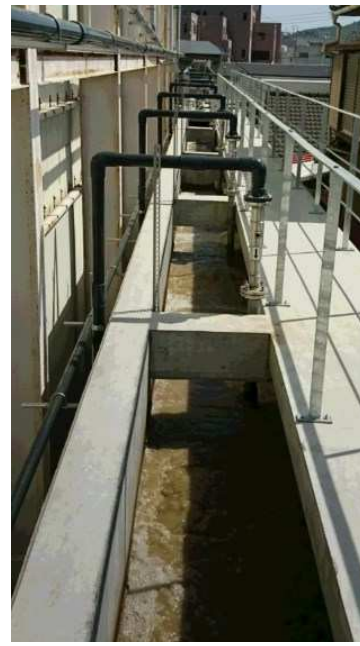
YJノズル「YJ-15」を調整槽に4台、「YJ-32-inline」を曝気槽に4台設置
