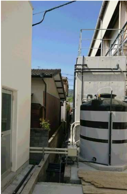
民家と曝気槽が隣接
