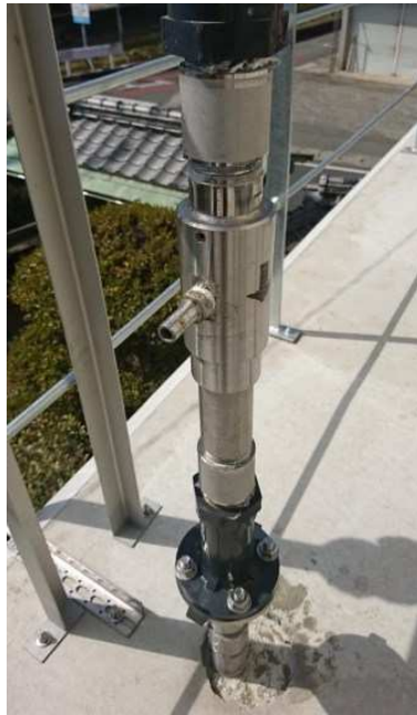
YJノズル「YJ-15」を調整槽に4台、「YJ-32-inline」を曝気槽に4台設置
