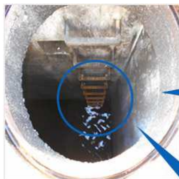
流量調整槽をマンホールから撮影した様子
